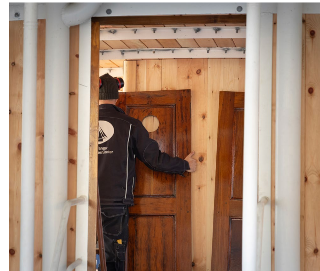
Restaurering av Jøssenfjord. Foto: Silje Ensby, HFS
