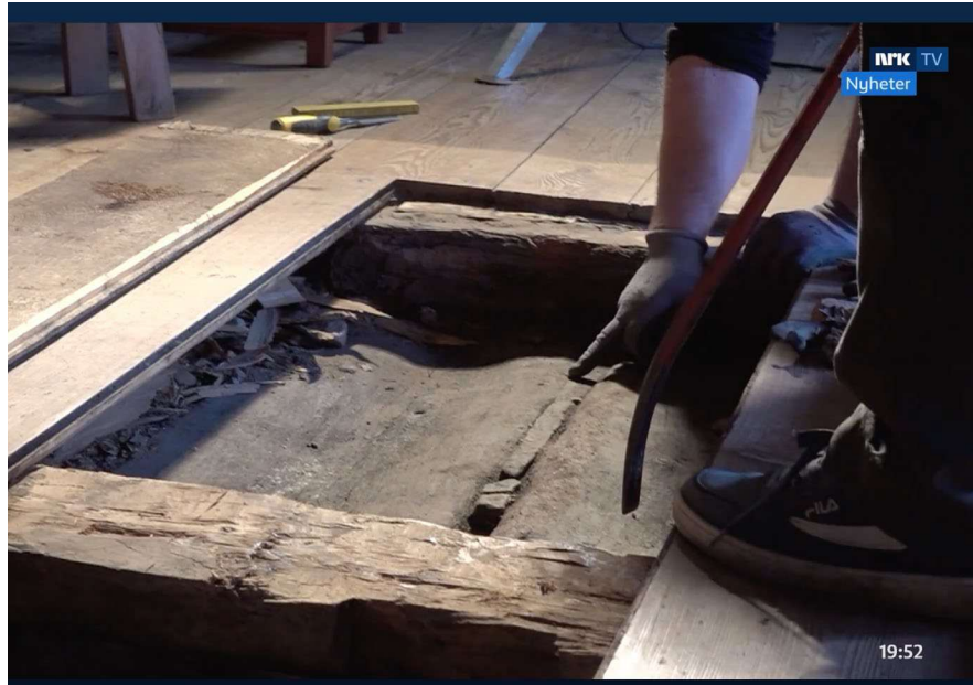
Våren 2025 vart to golvbord demontert i etasjeskilje i Lagmannstova. Under låg det eit hittil ukjend golv som viste seg å kunne vera svært gammalt. Foto: Skjermdump NRK Vestlandsrevyen 19.05.25.
