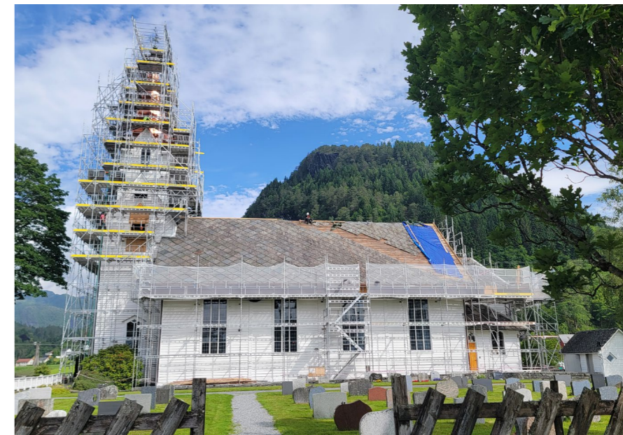
Strandebarm kyrkje har fått lagt om skifertaket og ny kopartekking på tårnet. Foto: Alexander Günther, HFS.
