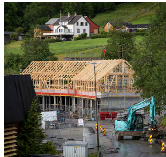
Reisverket til Handverkartunet er ein del av eit opplæringsprosjekt der studentar frå NTNU og Fagskulen i Vestland har stått for bygginga.
