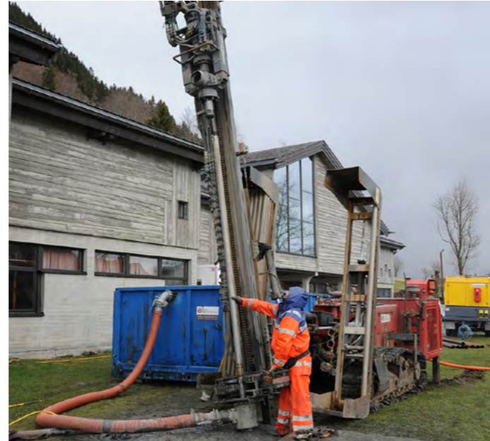
I 2024 er det gjennomført eit «grønt skifte» ved Voss folkemuseum, ved at me no hentar varme frå fire brønner som kvar er 220 meter djupe. Dessutan vart alle vindaugo og to dørar i fyrste høgda skifta. Foto: Kjell Herheim, VFM.
