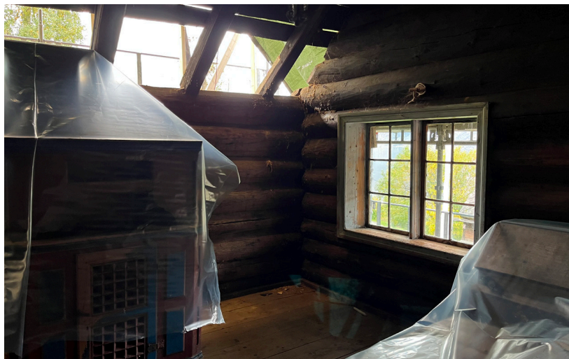
Kvalnesbua på Skredhaugen har blitt sikra og tilstanden vurdert etter at torva på taket raste ned.
